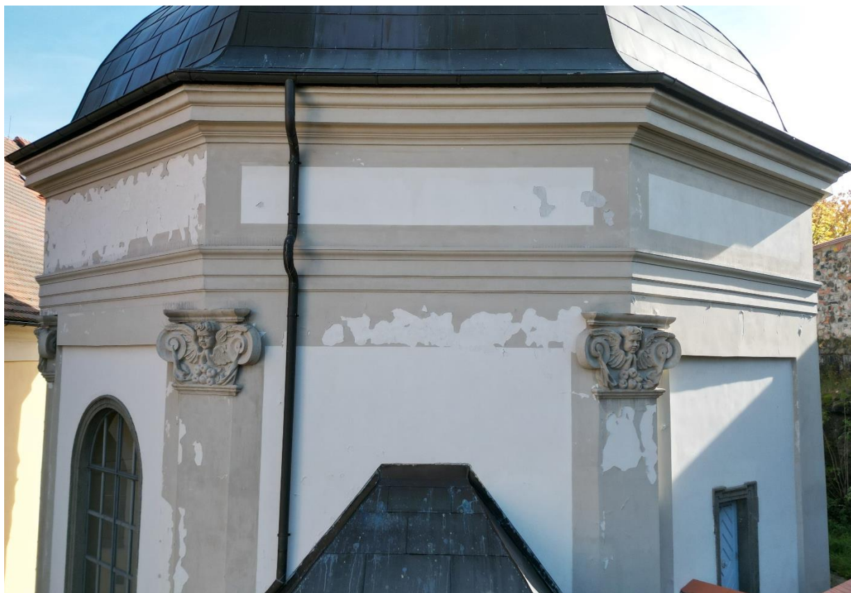
POŠKOZENÝ NÁTĚR VE VYŠŠÍCH PARTIÍCH FASÁD
