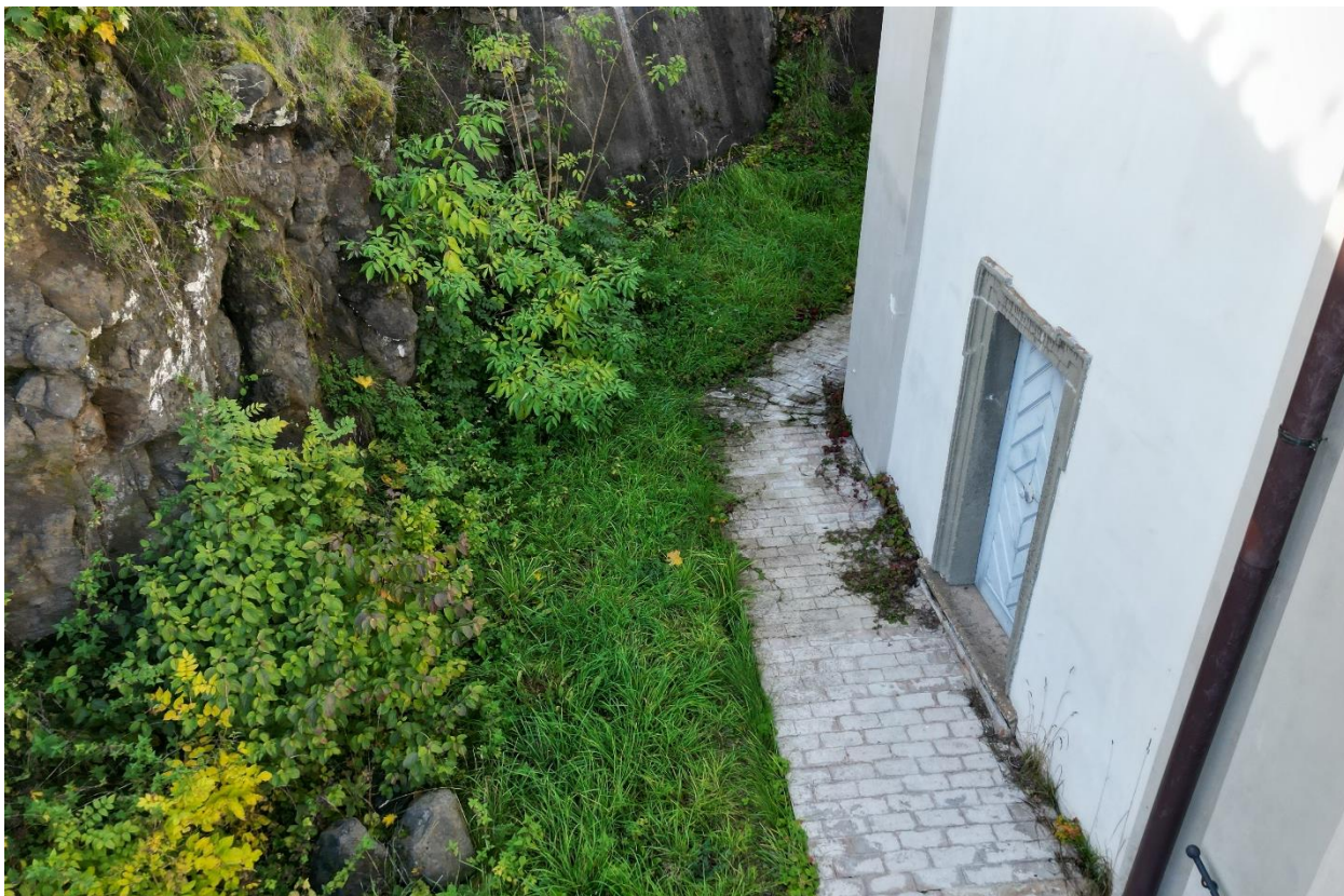
NÁLETOVÁ ZELENĚ A TRAVNATÁ PLOCHA PODPORUJÍCÍ ZASAKOVÁNÍ VODY K ZÁKLADŮM KAPLE
