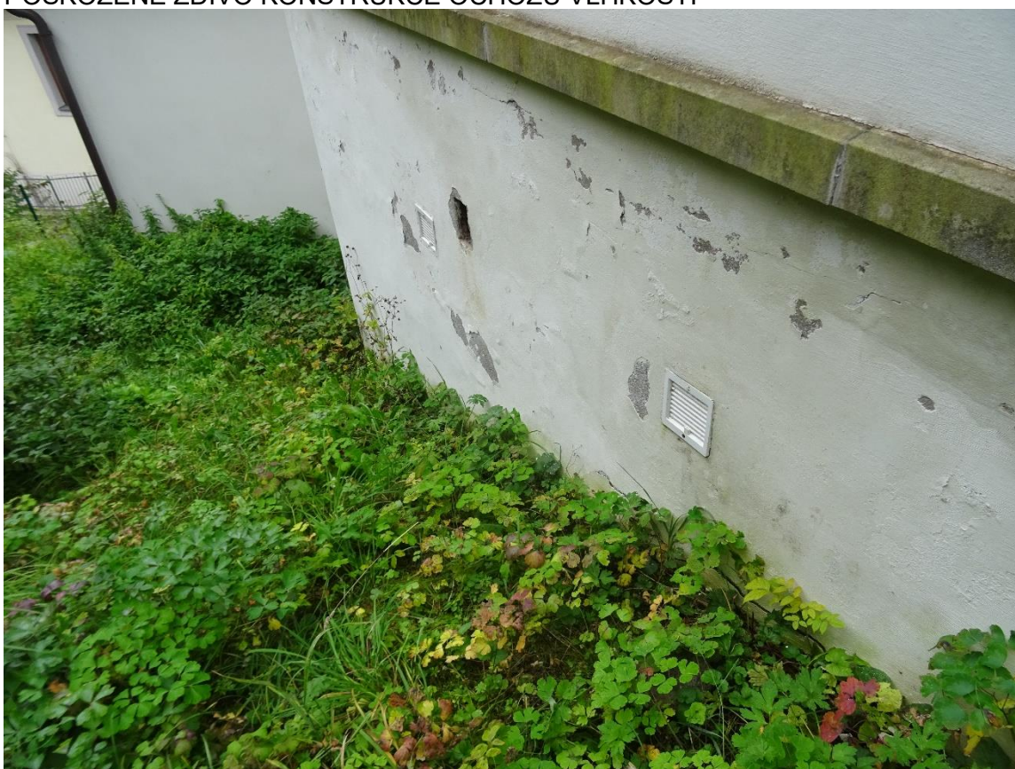
POŠKOZENÉ ZDIVO KONSTRUKCE OCHOZU VLHKOSTÍ
