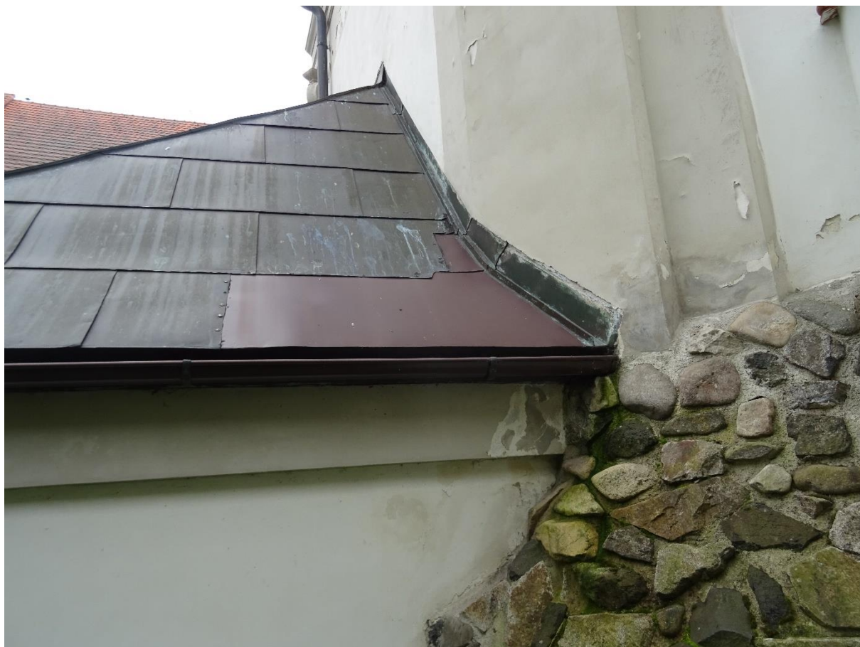
CHYBĚJÍCÍ ČÁST MĚDĚNÉ KRYTINY BOČNÍ KAPLE
