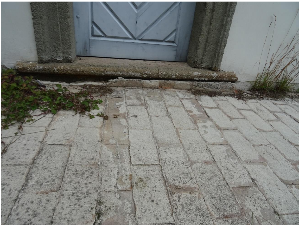
NEVHODNÁ NIVELITA TERÉNU (CHODNÍKU) - ZAPUŠTĚNÝ KAMENNÝ STUPEŇ
