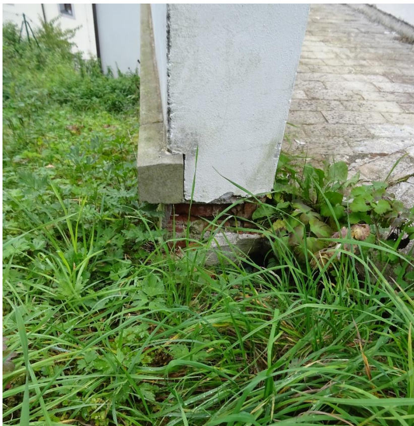
POŠKOZENÉ ZDIVO KONSTRUKCE OCHOZU VLHKOSTÍ
