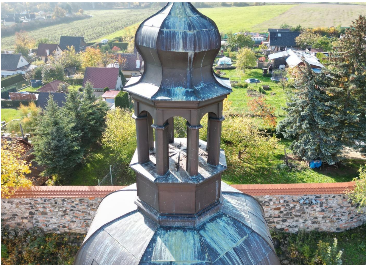
POHLED NA HORNÍ LUCERNU KAPLE Z VÝCHODU – ZNEČIŠTĚNÉ A POŠKOZENÉ OPLECHOVÁNÍ
