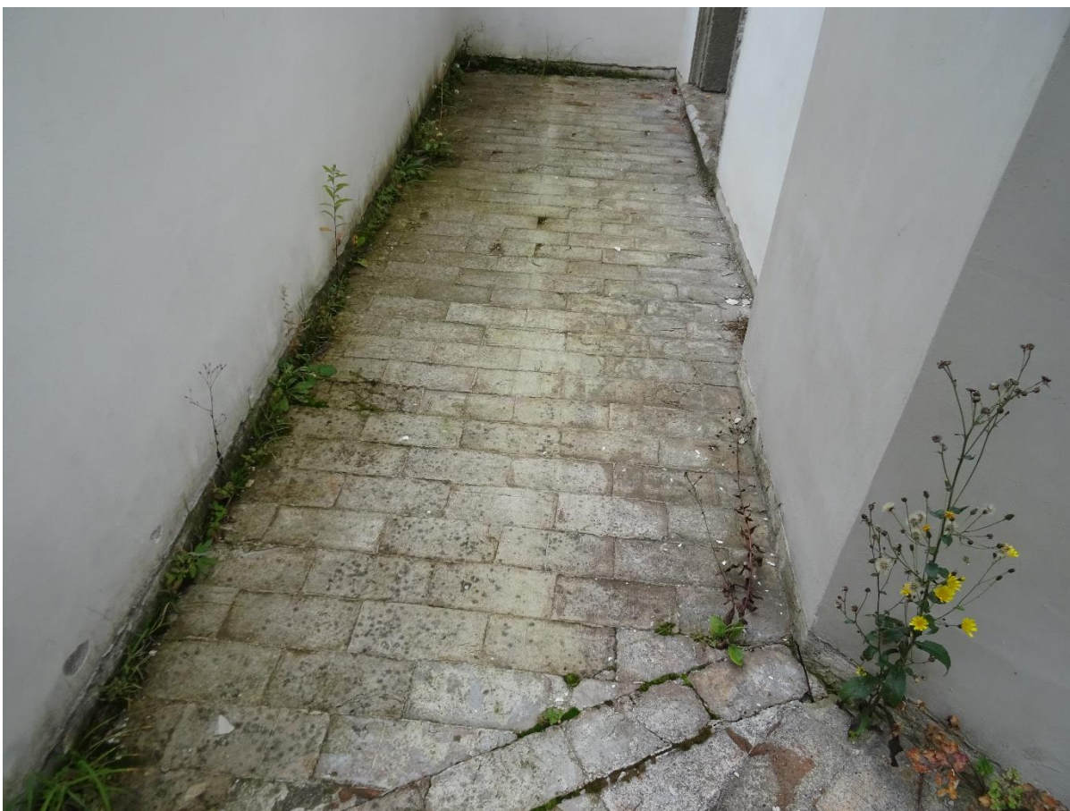
ZASAKOVÁNÍ VLHKOSTI POD KONSTRUKCI OCHOZU
