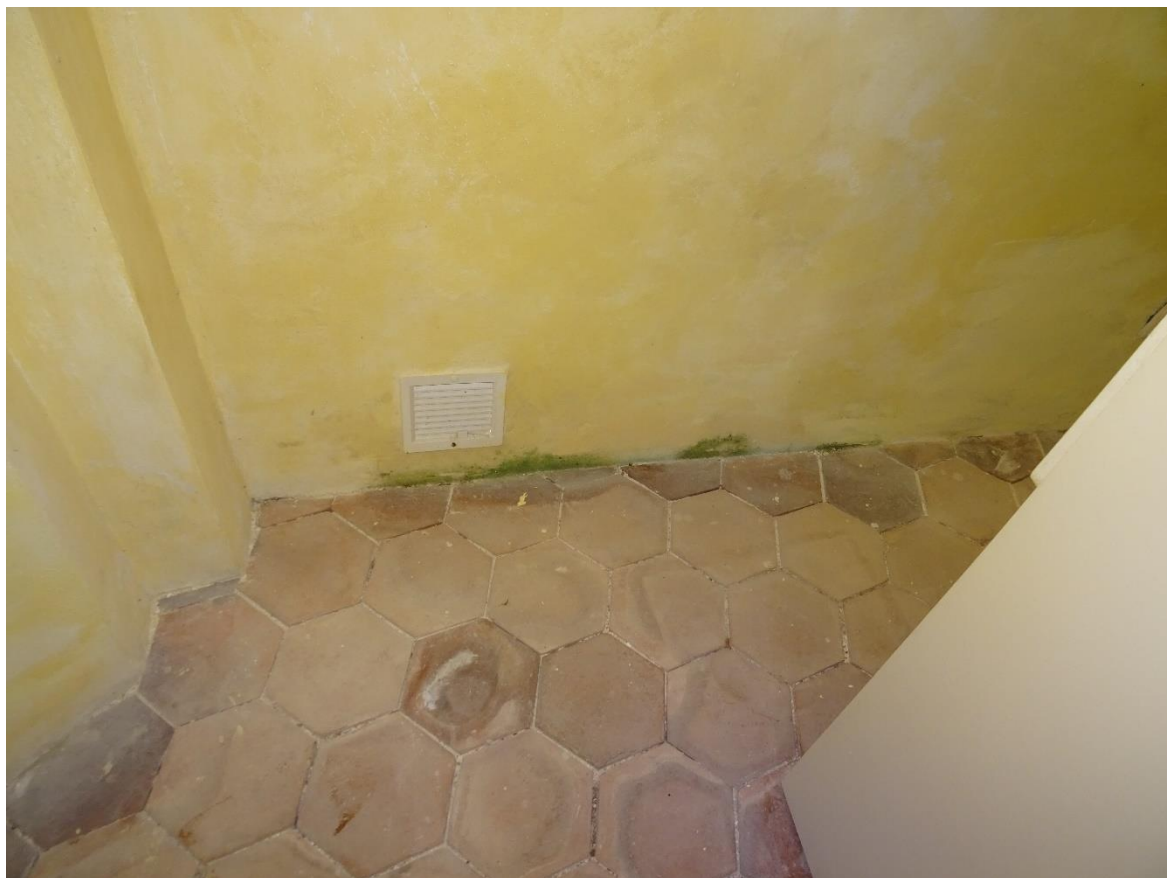
ZELENÝ POVLAK MIKROORGANISMŮ U PODLAHY KAPLE
