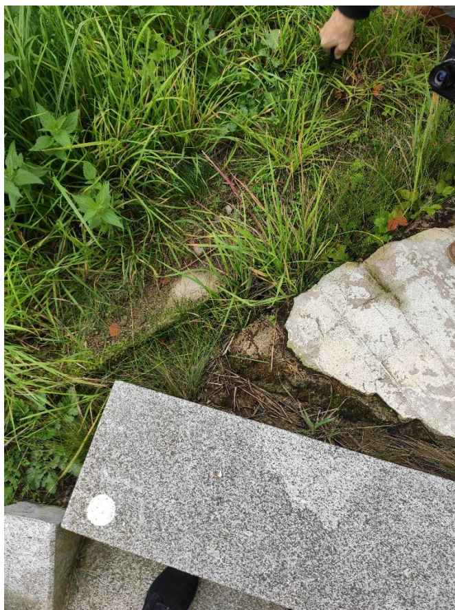
NEFUNKČNÍ ODVODŇOVACÍ ŽLAB
