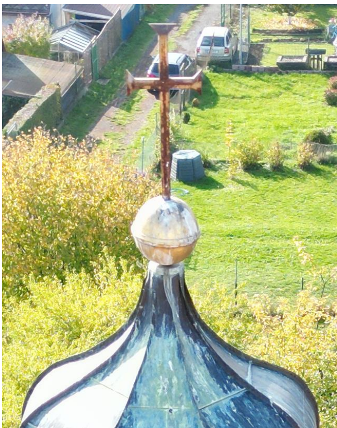
ZNEČIŠTĚNÝ A REZAVÝ KŘÍŽ S MAKOVICÍ
