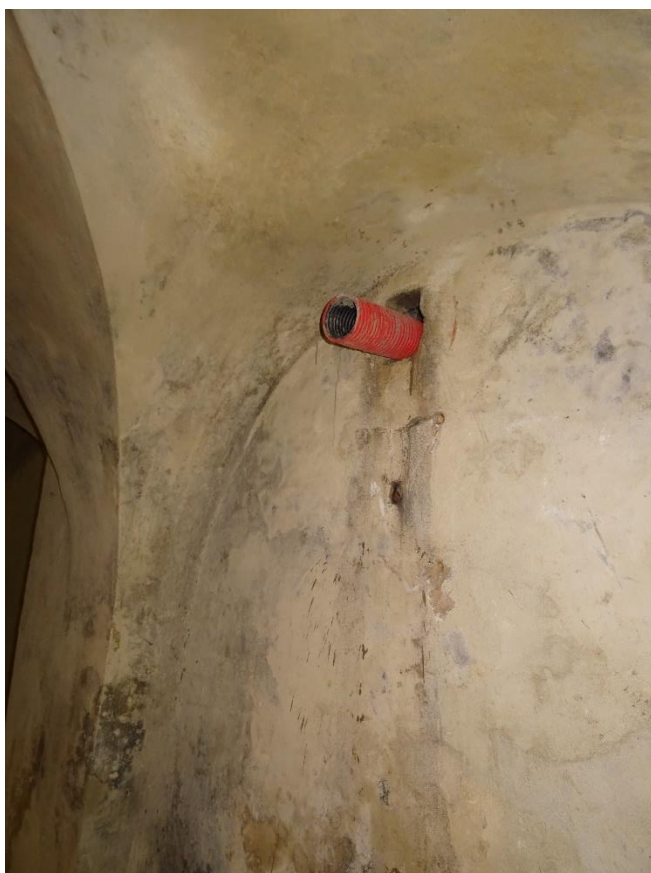
NEDOKONČENÉ PROVEDENÍ ODVĚTRÁNÍ KRYPTY
