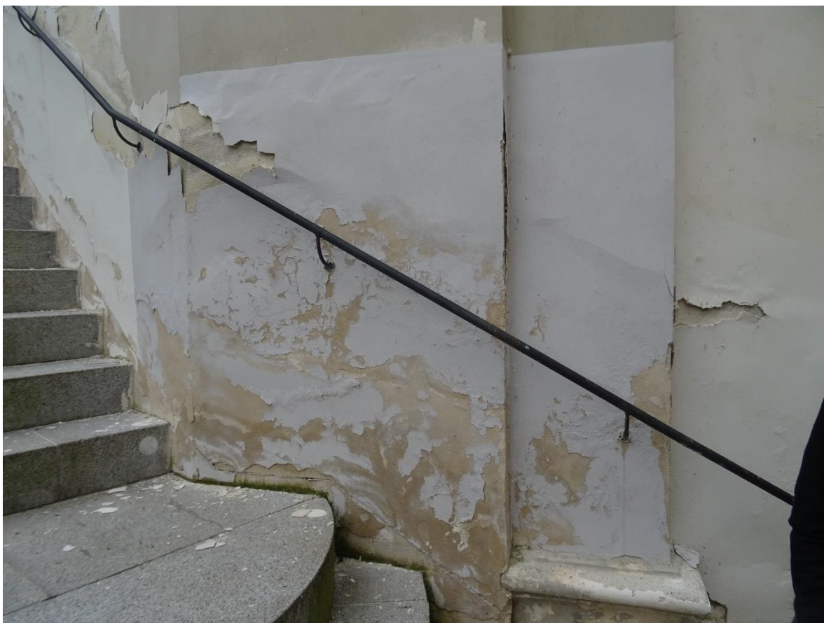
FASÁDA POŠKOZENÁ VLHKOSTÍ
