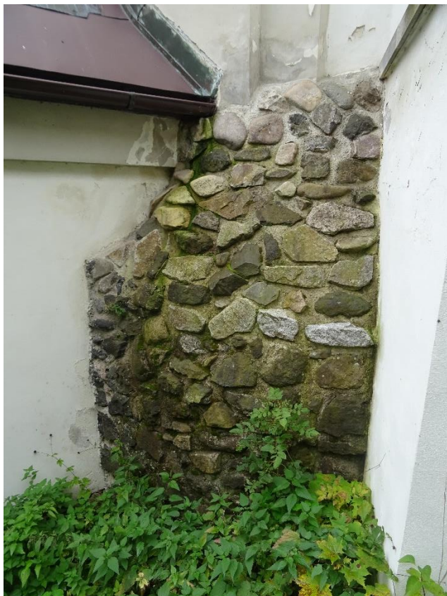
ZAVLHČENÝ KAMENNÝ OPĚRÁK
