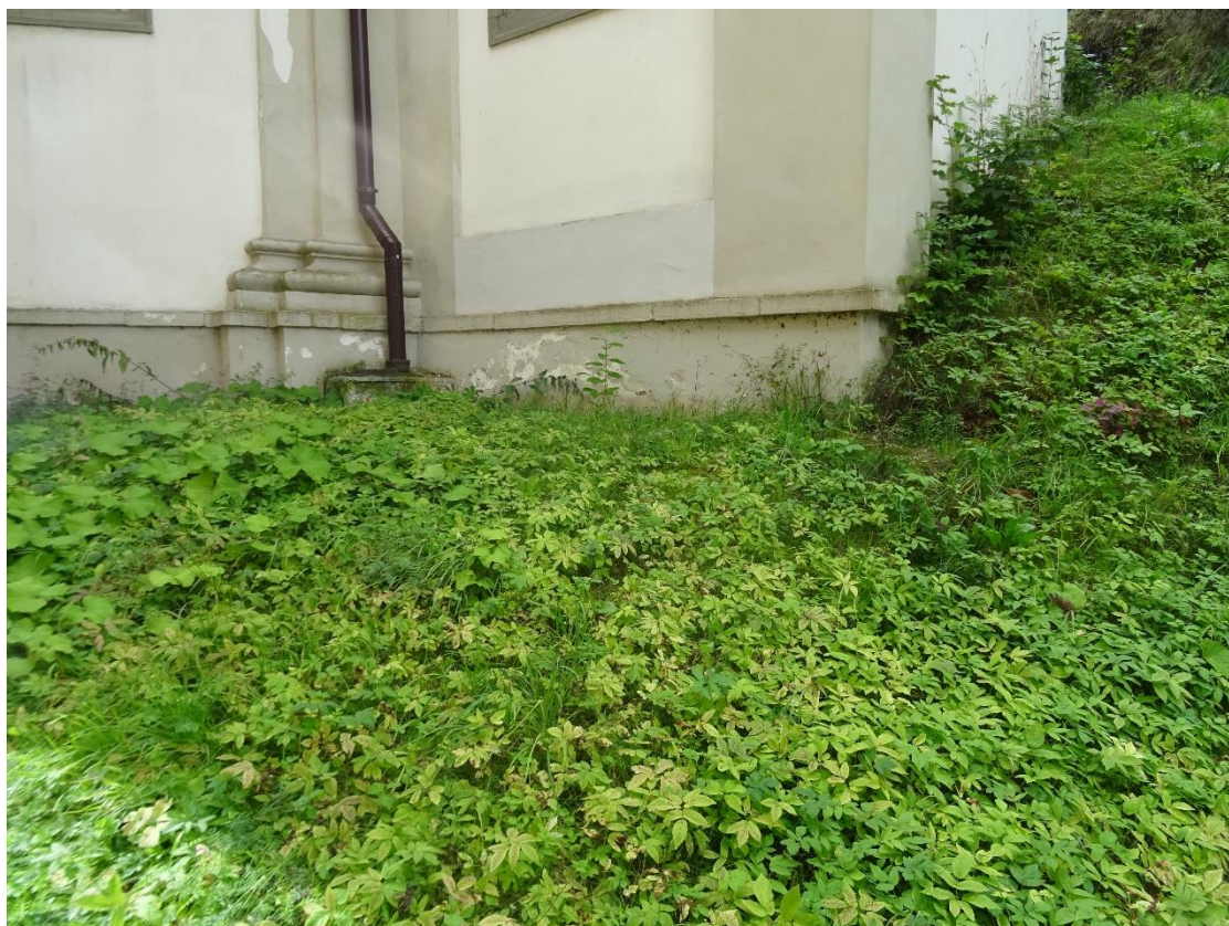
ZAROSTLÝ OKAPOVÝ CHODNÍK KOLEM KAPLE, NEVHODNĚ VYVÝŠENÁ POZICE LAPAČE STŘEŠNÍCH SPLAVENIN
