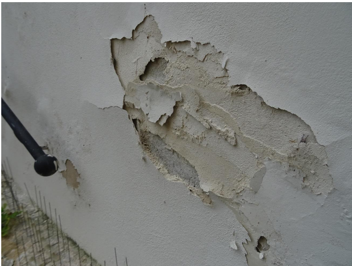
DETAIL POŠKOZENÍ NÁTĚRU, ŠTUKOVÉ VRSTVY A OMÍTKY
