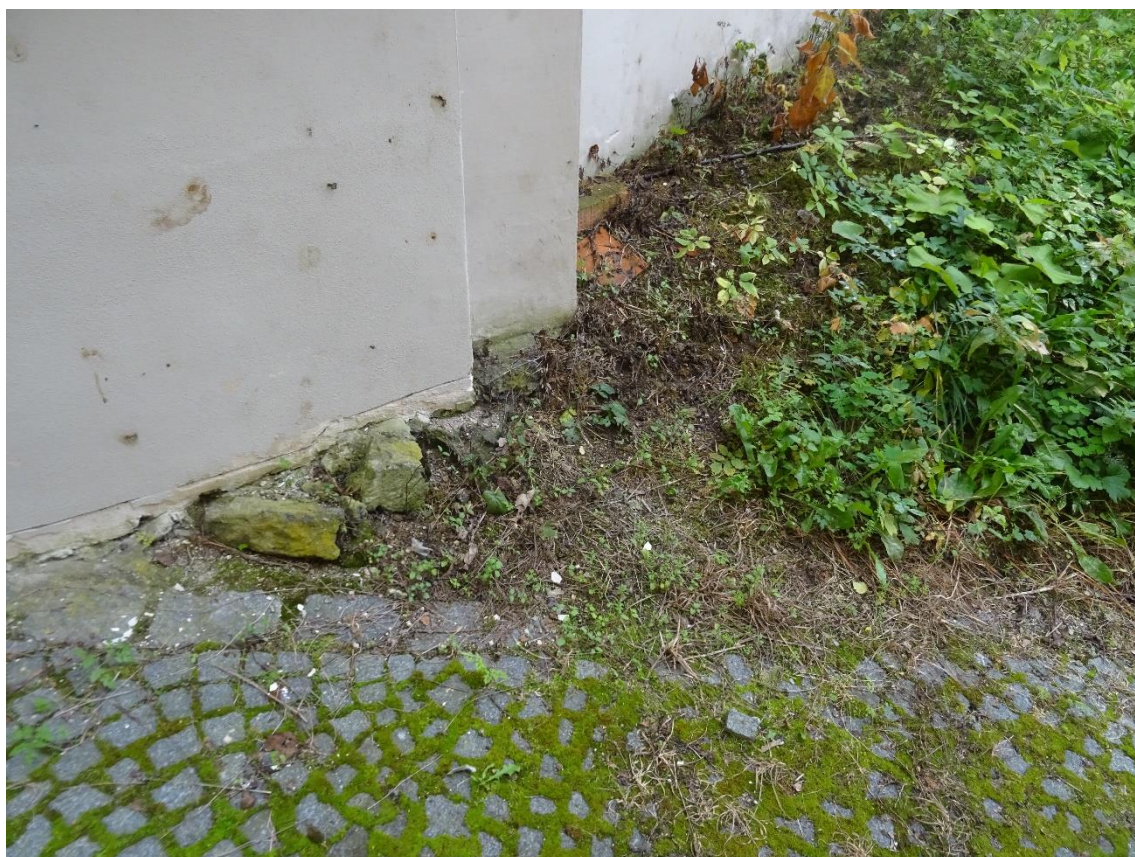
CHYBĚJÍCÍ A ZAROSTLÝ OKAPOVÝ CHODNÍK – NEVHODNĚ PROVEDEN Z CIHEL
